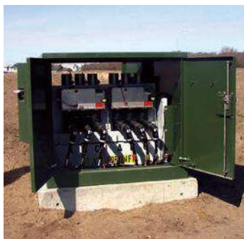
Montaje de pedestal
